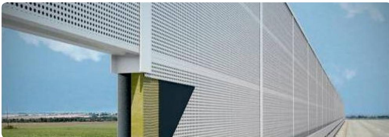
Los paneles de lana de roca Cibel, poseen excelentes propiedades de aislamiento acústico. Este producto está constituido por paneles machihembrados, compuestos por planchas de metal en 0,5 mm + 0,5 mm. Calidad STM 653, fabricados con una capa aislante construida por tiras de fibra mineral biosoluble, lana de roca de alta densidad 100 Kg./m<sup>3</sup>. Cara interior microperforada fonoabsorbente acústico. El panel tiene una reacción al fuego: clase A2.s1, d0.
