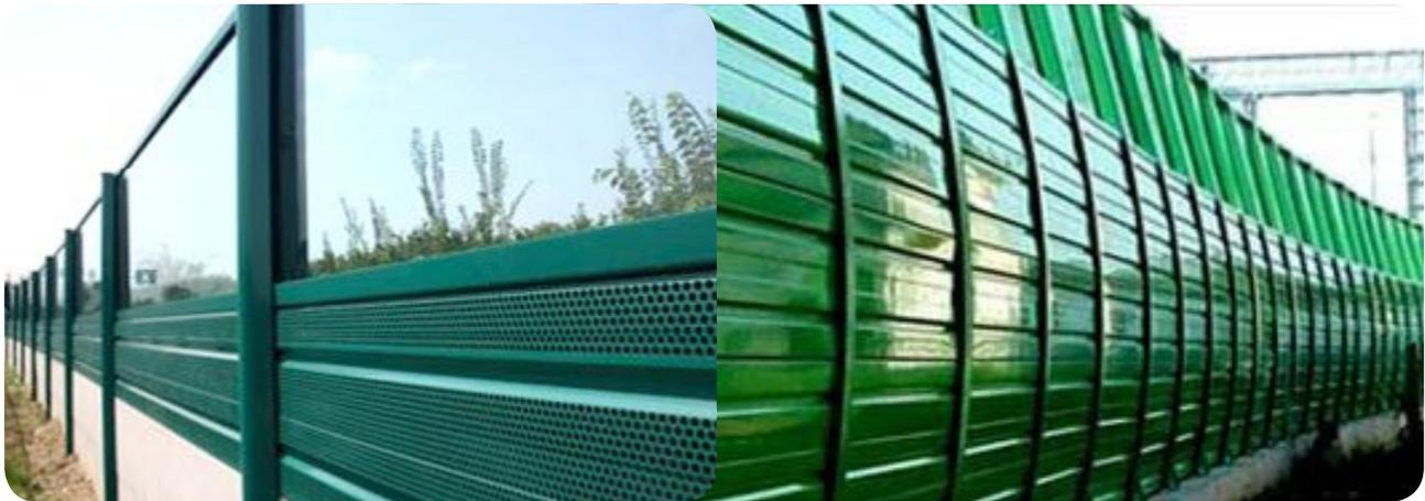
Las barreras acústicas tienen la función de interponer un obstáculo a la propagación sonora entre una fuente y un receptor.
