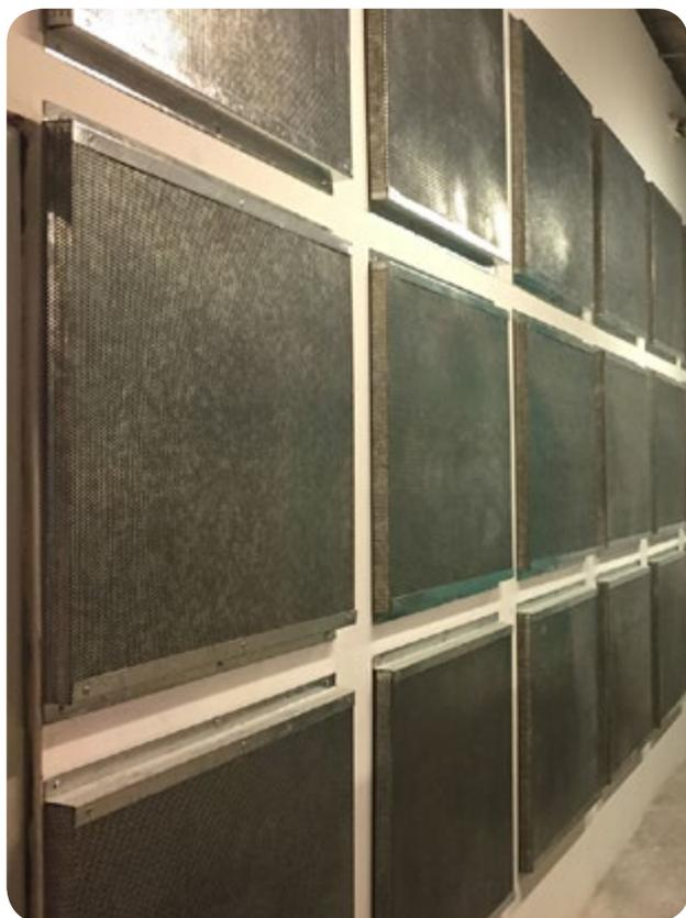
El panel fonoabsorbente metálico modular Cibel, es fabricado con lana de vidrio de 50 mm. de espesor y densidad de 35 Kg/m<sup>3</sup>, su terminación interior es de plancha metálica galvanizada y perforada al 35%, con un diámetro de perforación entre 3 a 5 mm. Con un NRC > 0,8.
