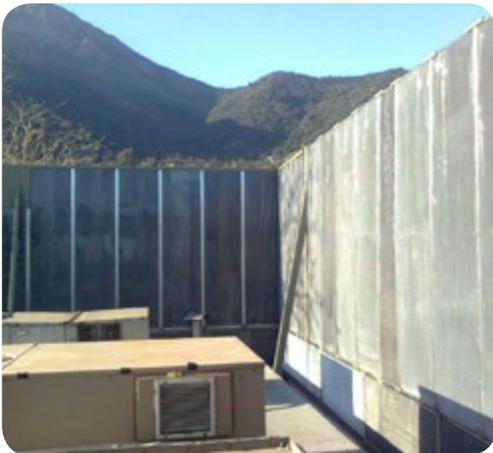
Paneles acústicos en equipos de climatización azotea edificio corporativo.
