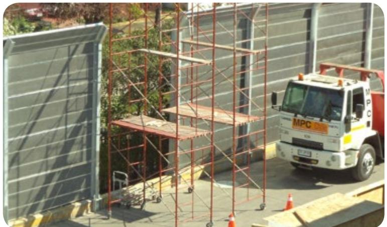
Paneles utilizados en barrera acústica perimetral. Proceso de montaje.
