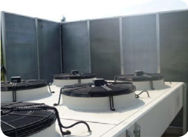
Apantallamiento acústico hecho con panel acústico modular metálico en central de frío local equipos condensadores en supermercado.
