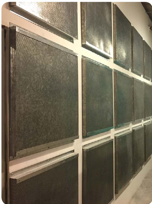
El Panel Fonoabsorbente Metálico Modular (Cibel PFA50), es fabricado con lana de vidrio de 50 mm. de espesor y densidad de 35 Kg/m<sup>3</sup>, su terminación interior es de plancha metálica galvanizada y perforada al 35%, con un diámetro de perforación entre 3 a 5 mm. Con un NRC > 0,8.
