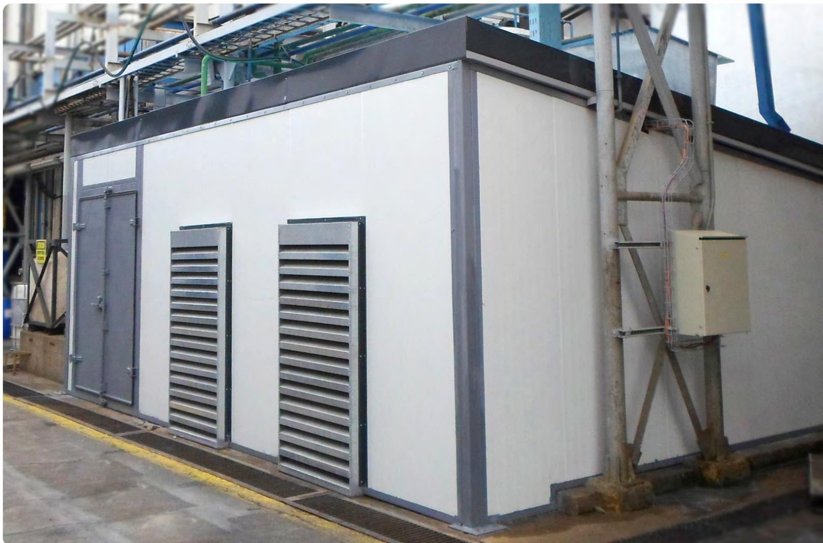
Insonorización en sala de bombas. Panel lana de roca, celosías louver y portón acústico.
