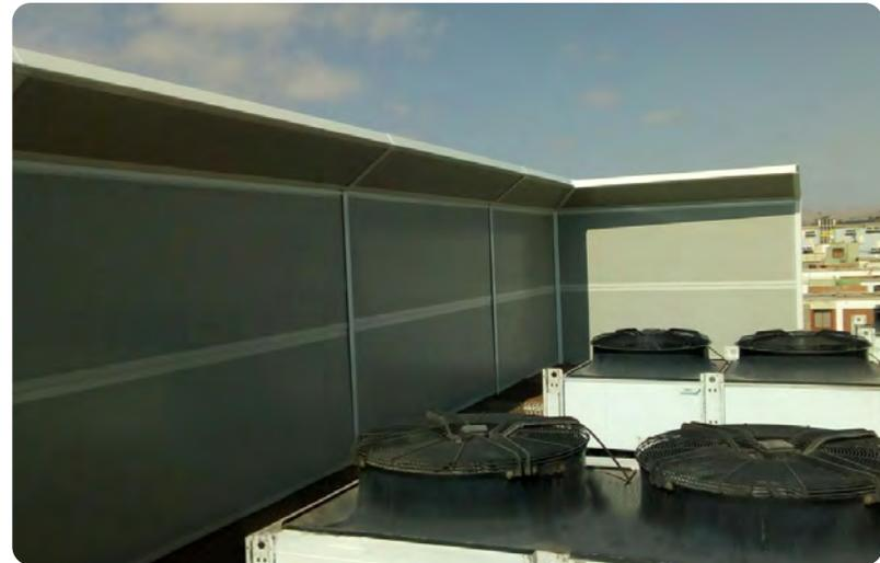
Apantallamiento acústico en equipos de condensadores.
