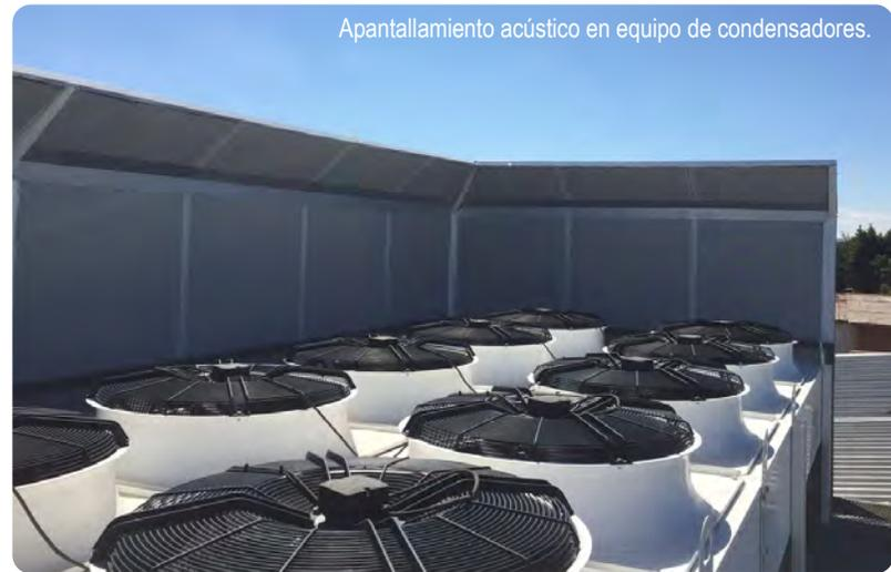
Apantallamiento acústico en equipo de condensadores.
