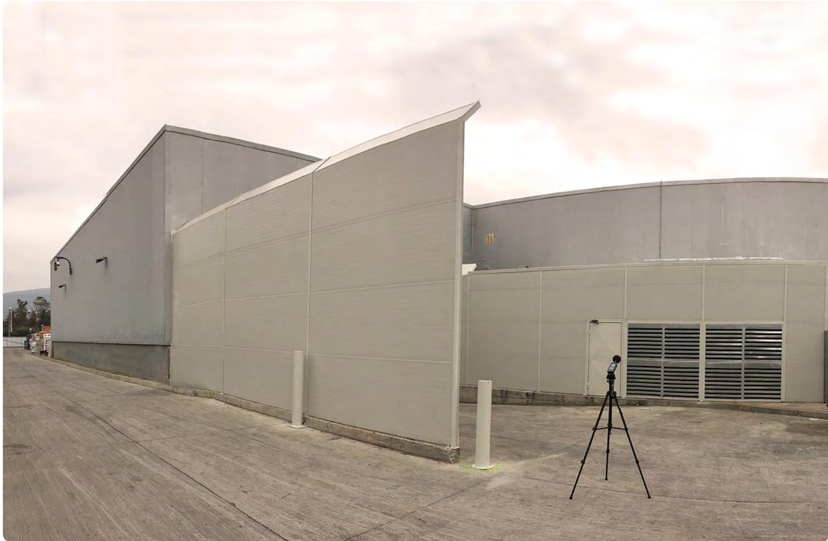
Implementación de medidas de control de ruido. Barrera acústica panel lana de roca e insonorización en central de frío.
