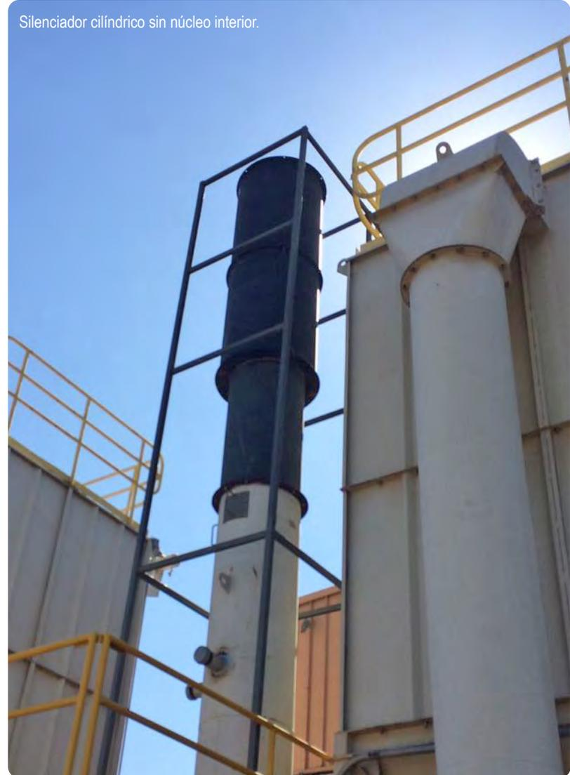
Silenciador cilíndrico sin núcleo interior.
