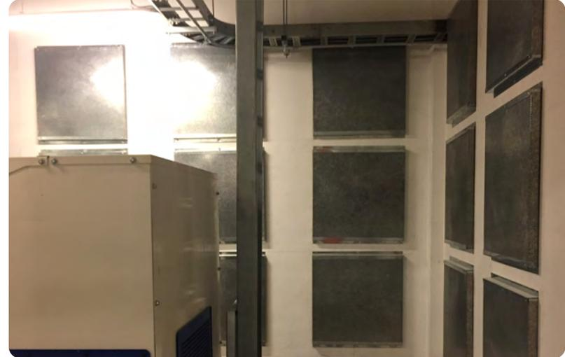
Acondicionamiento acústico en sala grupo electrógeno. Panel fonoabsorbente metálico modular.
